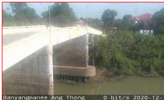
Banyangmanee Ang Thong 0 bit/s 2020-12-1 สถานีบ้านยางมณี ต.องครักษ์ จ.อ่างทอง (ลุ่มน้ำเจ้าพระยา)
